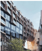
Nová bytová budova v Praze, která je připojena k sítí Pražské teplárenské.
